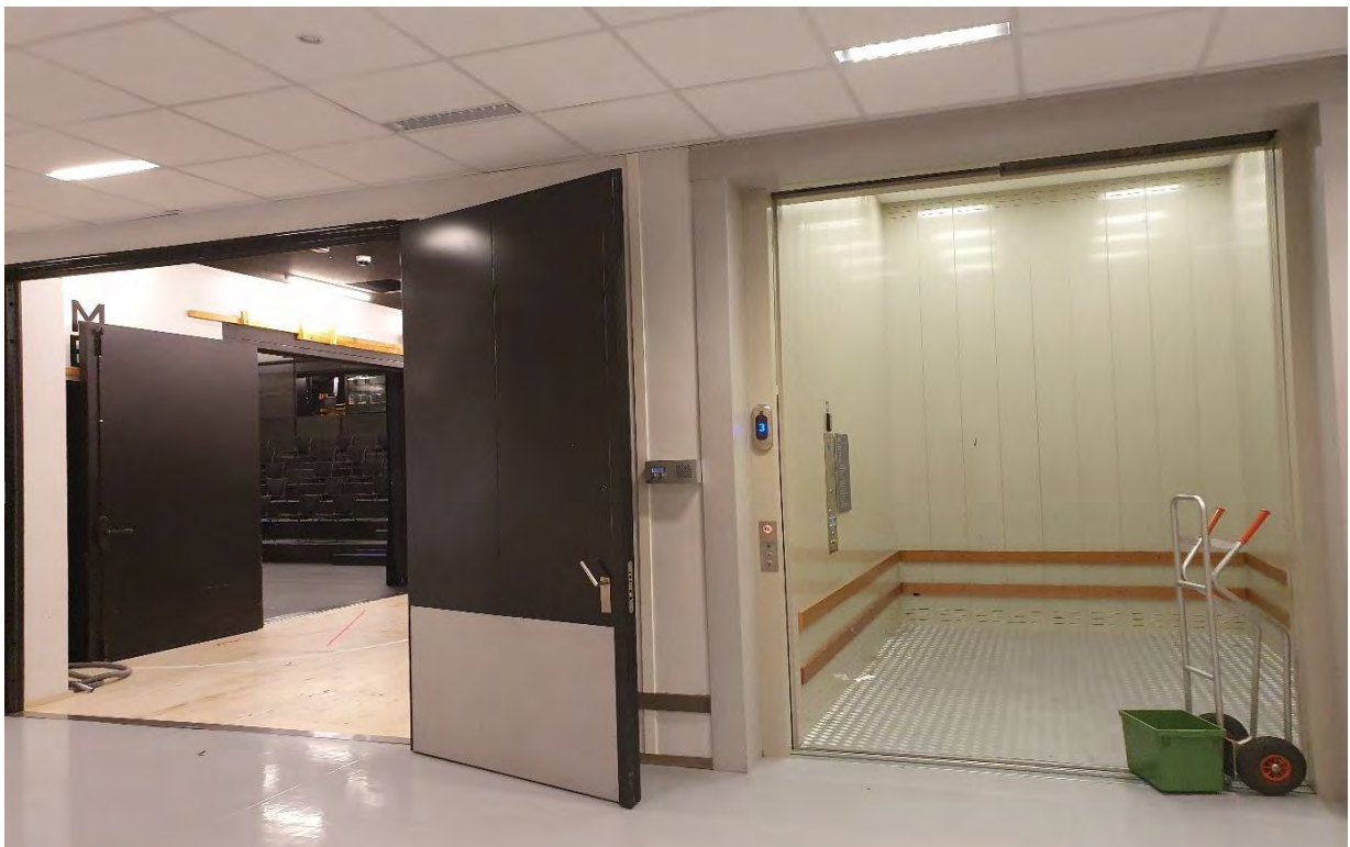
Adgang til scene fra heis i 3. etasje.
