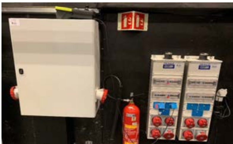
125 A 3p and 2 x 63-amp skap scene høyre.
