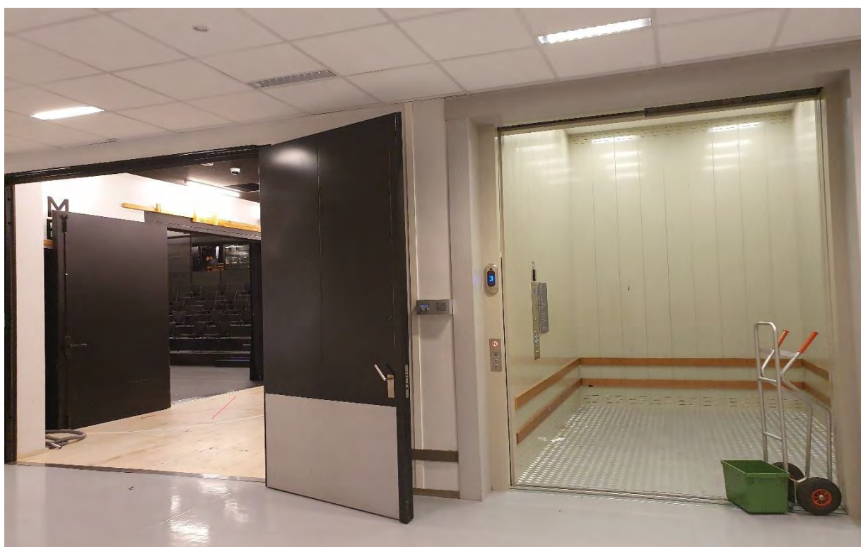
Adgang til scene fra heis i 3. etasje.
